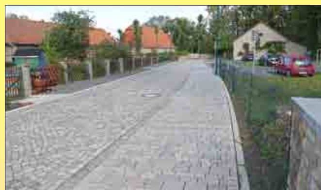
Brauereistraße vor und nach der Sanierung
