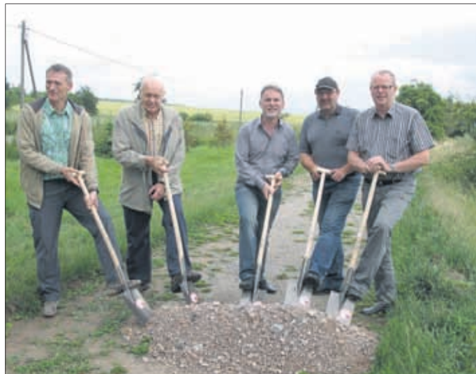
v.l. Setzen gemeinsam den ersten Spatenstich für den Radweg zwischen Kirchheilingen und Tottleben: Mike Hoppe (Planungsbüro Oppermann), Klaus Schwarzkopf (Bgm. Kirchheilingen), Landrat Harald Zanker, Steffen Mörstedt (Bgm. Tottleben) und Rüdiger Aust (Aust EKS Bau AG).
